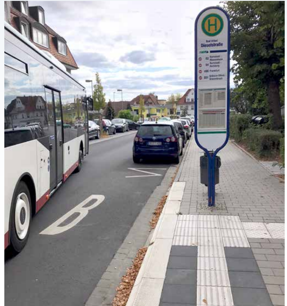
Abbildung 22: Haltestelle mit nicht ausreichend dimensioniertem Parkverbot im An- und Abfahrtsbereich
