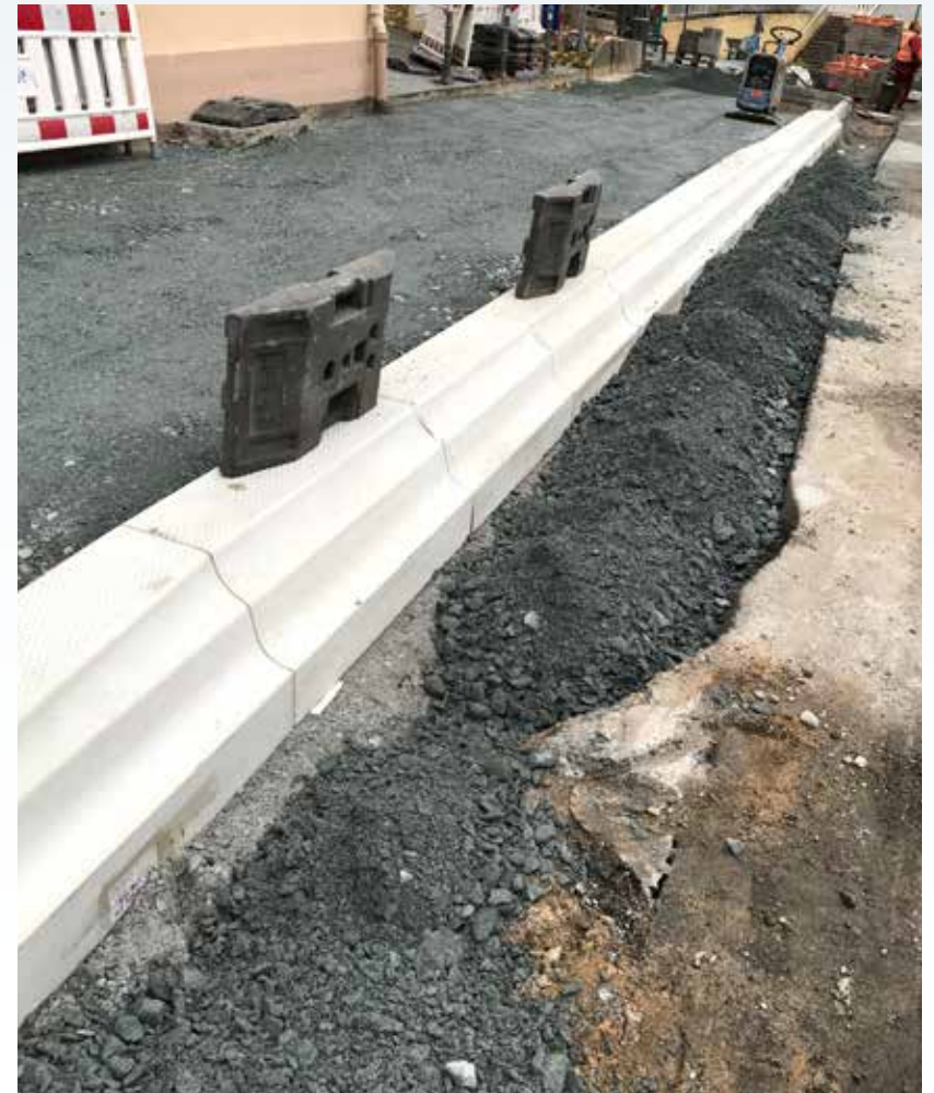
Abbildung 20: Einbau eines Hochbordes während der Baumaßnahme
