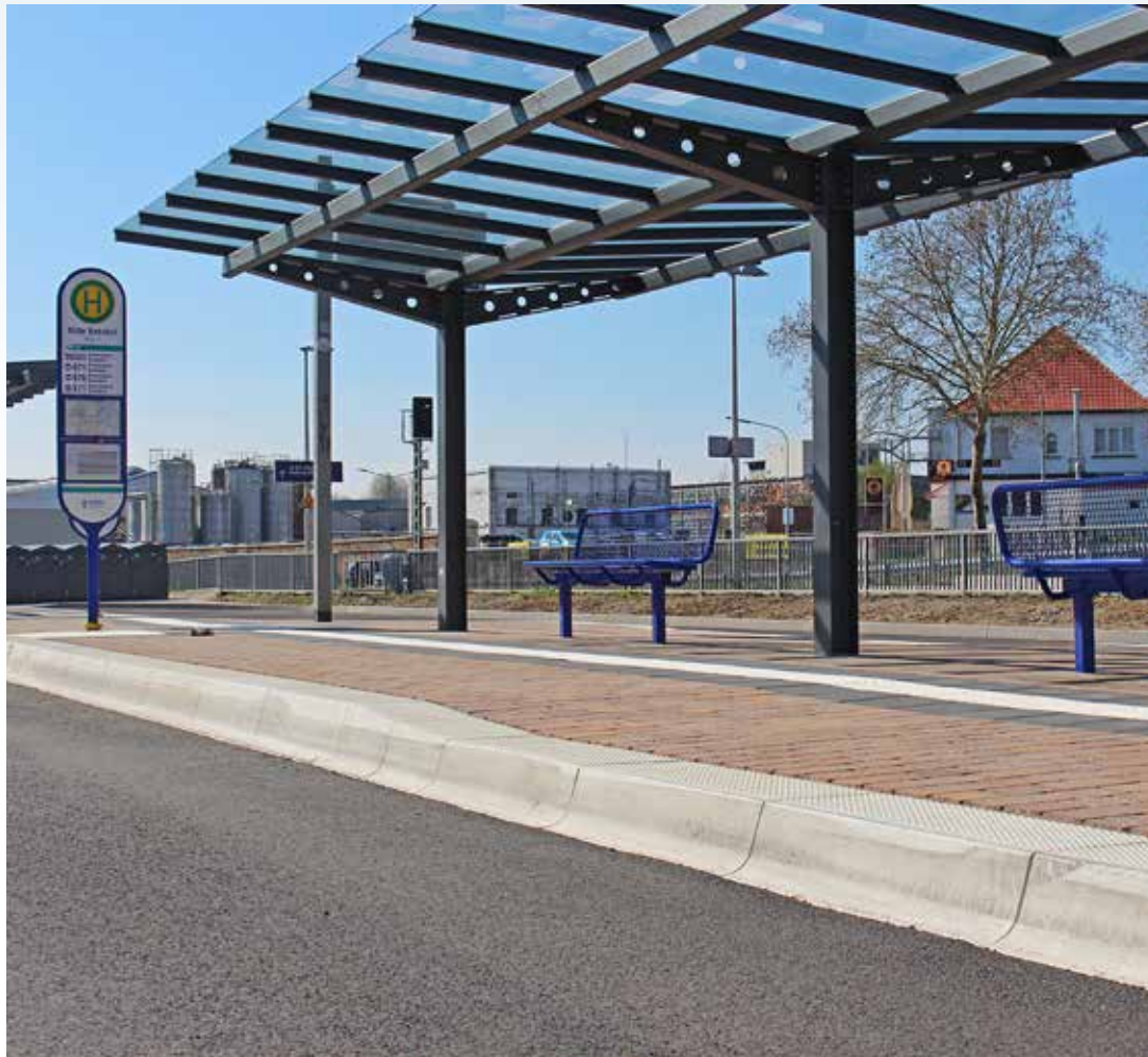
Abbildung 19: Haltestelle am Bahnhof Groß-Umstadt während der Baumaßnahme
