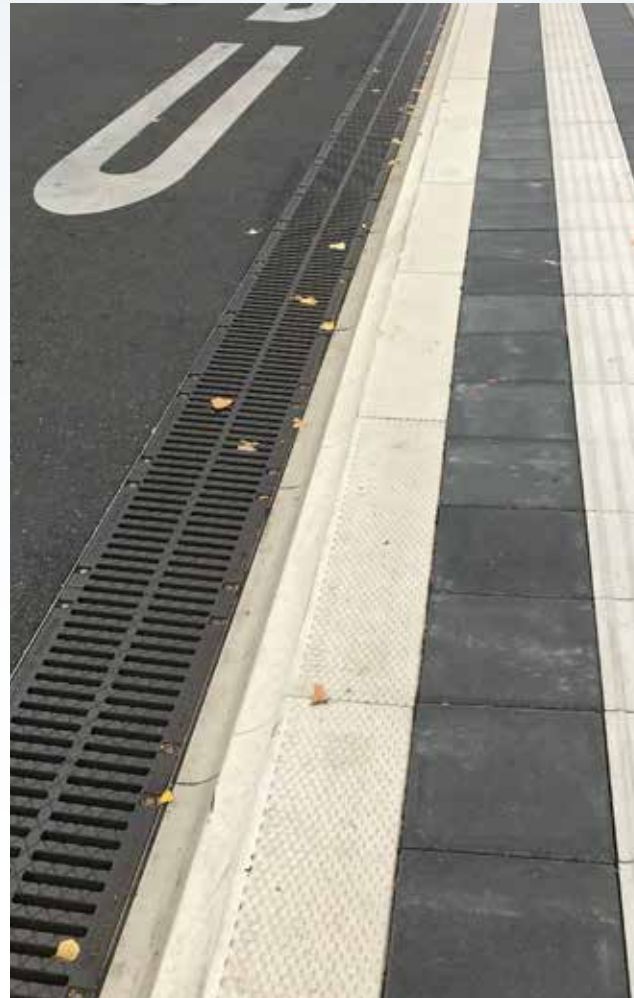
Abbildung 27: Haltestelle mit Spurführung und zweiter Hohlkehle
