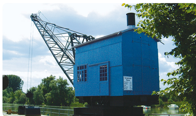
3 Ginsheimer Altrheinufer: Kran
