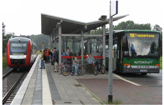
Bild 7: Kombibahnsteige, an denen bequem zwischen Zug und Bus und intermodal zu Rad-, Bus-, Fuß- und Autoverkehr umgestiegen werden kann, sind im Deutschlandtakt wichtiger denn je. Hier die Station Ruckling an der 2002 reaktivierten Strecke Neumünster-Bad Segeberg. Quelle: Bahnstadt, Planungsgesellschaft für Bahnhofsentwicklung mbH
