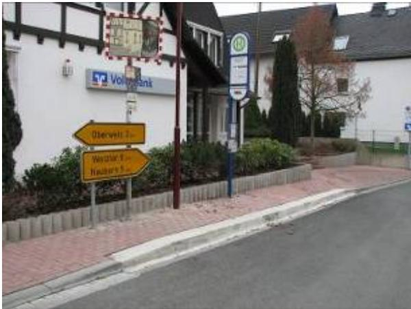
Abbildung IV-5: *Beispiel für eine Haltestelle, bei der ein Hochbord eingebaut wurde. Aufgrund der zu schmalen Aufstell- und Manövrierfläche ist die Haltestelle trotzdem nicht für Menschen im Rollstuhl nutzbar [Foto: VLDW]*
