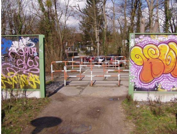
Abbildung 12: BÜ km 0,75 „Am Judenteich“ mit Umlaufsperre
